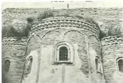
Собор Крыпецкого монастыря. Фрагмент алтарных апсид
