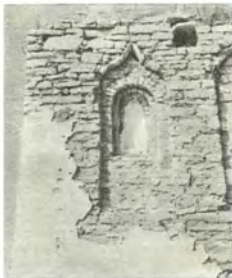
Окно церкви при трапезной Крыпецкого монастыря. XVI в.
